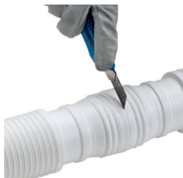
Κοπή του εύκαμπτου συστήματος μεταξύ 2 θηλυκών τμημάτων της κουλούρας (η κοπή μπορεί να γίνει πριόνι ή άλλο αιχμηρό κοπτικό εργαλείο εφόσον καθαριστούν τα γρέζια εν συνεχεία)
